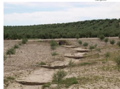
Figura 6: Concepto de control de cárcavas con diques de retención (arriba) y ejemplo en un olivar (abajo).
