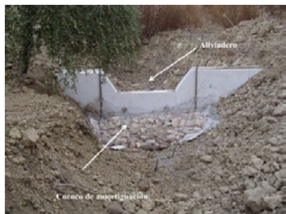
Figura 8: Ejemplo de aliviadero y cuenco de amortiguación en un dique de retención.
